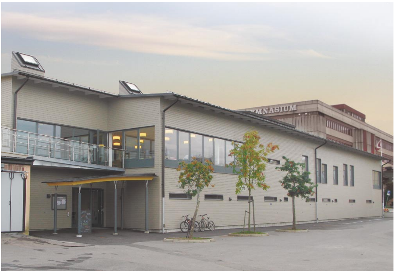
Tibblevallens omklädningsbyggnad, med kaféet över entrén.
